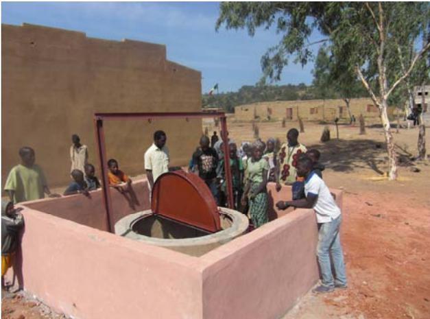
Zur Verbesserung der **Trinkwasserversorgung** auf dem Schulgelände wurde in 2015 ein Schachtbrunnen gegraben. Nachdem man im Zuge der Baumaßnahmen im Vorjahr auf felsigen Untergrund stieß, wurde über eine geophysikalische Untersuchung ein geeigneter Standort ermittelt. Der Brunnen ist 20 m tief. Auch in den Orten Wadjan und in Manfilana, die ebenfalls zur Kommune Dombila gehören, wurden professionelle Trinkwasserbrunnen gegraben.
